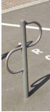
La surface d'appui est faible; le vélo est mal stabilisé. D'autant plus vrai pour l'épinglé S.
